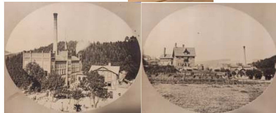
Gebäude der Stiftung Wohlfahrt
