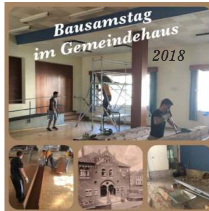
das Gemeindehaus 1905 erbaut, wird hergerichtet für die heutige Zeit.
